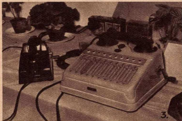
3. LB 10-es kiskapcsoló prototípusa. Az üzem műszaki fejlesztési tervében szereplő kiskapcsoló
